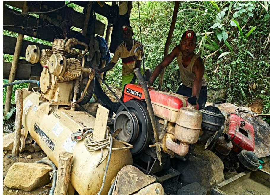
Compresseur d'air (Carrubba)
