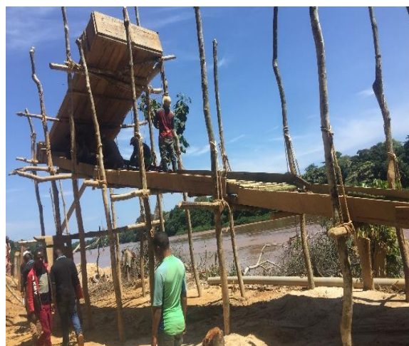
Photo 21 : Sluice (table de lavage) commençant à une grande hauteur. Avakubi (Tshopo)
